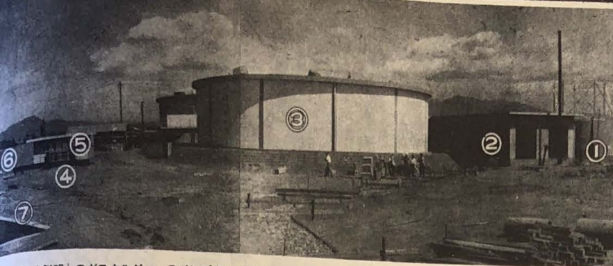
【写真説明】①ガスホルダー ②ポンプ室 ③消化槽 ④沈澱池 ⑤第二ポンプ室 ⑥撒布濾床 ⑦汚泥乾燥床。なお写真に見えないところに事務所、高架水槽、脱硫槽、貯溜槽投入槽、計量減菌槽があります。
