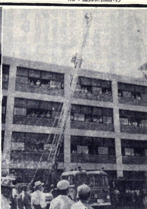
消防に新威力、ハシゴ車の新設
