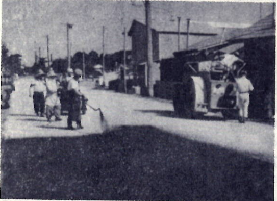
北部環状線を完全舗装
