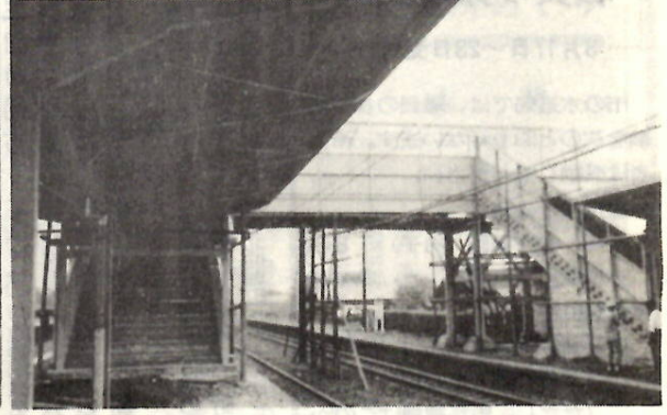
工場進出で群馬総社駅に二線橋完成
