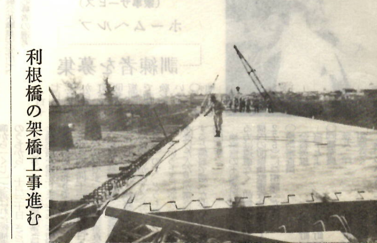
利根橋の架橋工事進む
