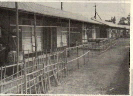
厚生住宅二二戸青梨子町に建設
