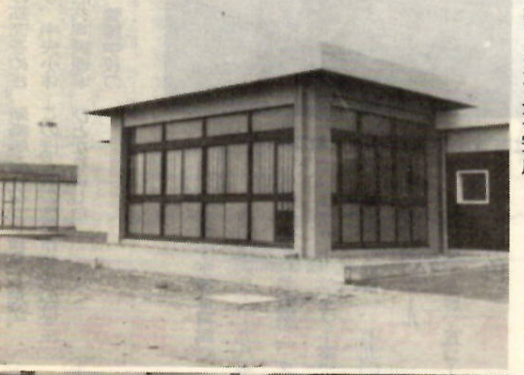
野中水源工事完成
