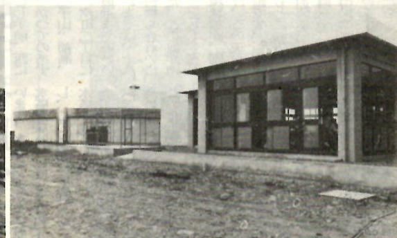
野中水源完成
