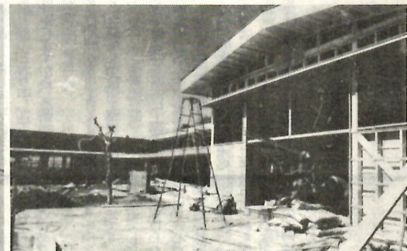
上川測保育所改築
