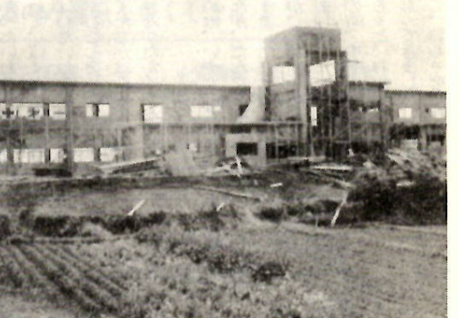
合同校舎の建築進む(右上)
