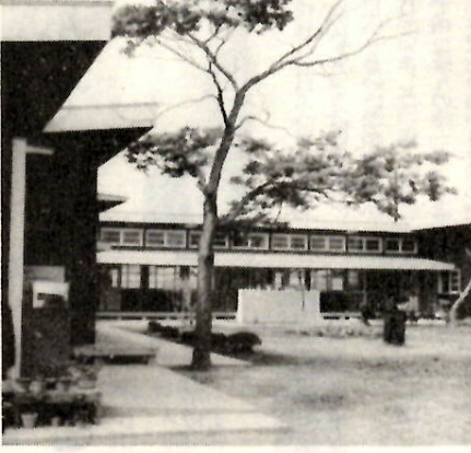
上川淵保育所完成(上)
