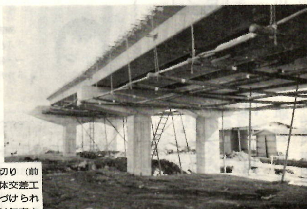
上越線総社町踏み切り(前橋-箕郷線)の立体交差工事は急ピッチでつづけてられています。
