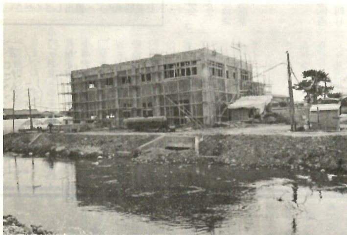
下水道計画の前進、天川町にポンプ場を着工
