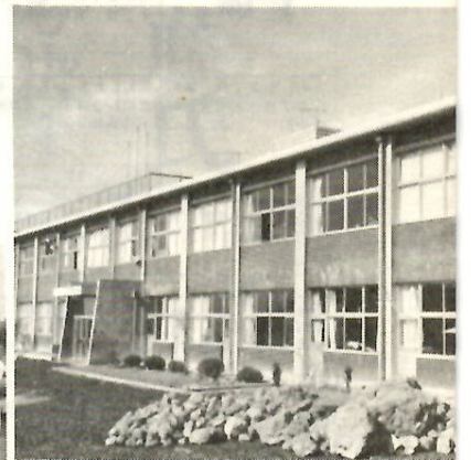
嶺小学校統合校舎完成、体育館も
