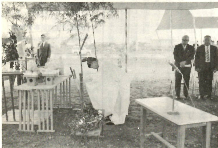
問屋センター造成工事はじまる (その起工式)
