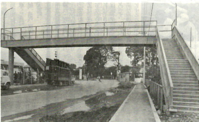
プール付近に歩道橋を新設
