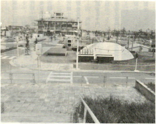
十月の開園をめざして工事中の公園と児童文化センター
