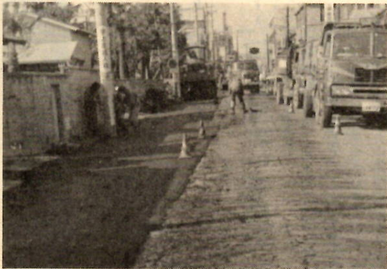
道路舗装などの工事も失業対策事業のひとつとして行なわれます。
