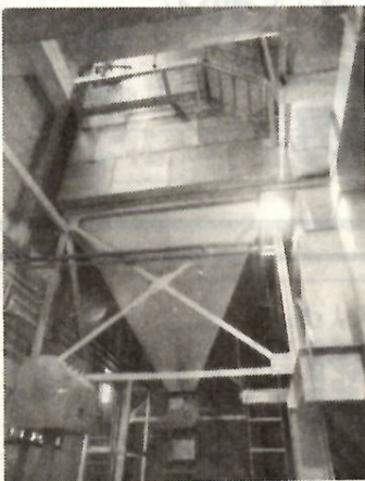
●マルチサイクロン 煙の中のばい塵をとり除く装置です。
