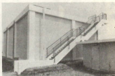
清里水源に完成した配水池
