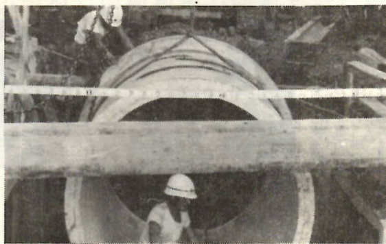
下水道管の布設作業
