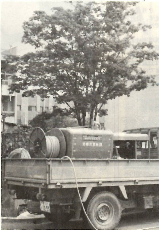
市では、高木の防除用として大型動力噴霧機スワースプレーヤーを導入しました。この機械は、大発生地域の高木防除の際に大いに偉力を発揮してくれるでしょう。
