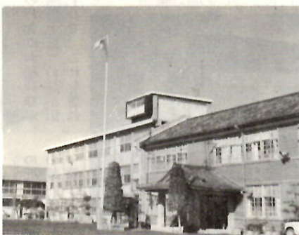
芳賀中学校舎と体育館
