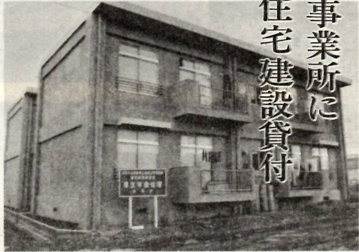
昨年建設された厚生年金住宅(天川大島町)
