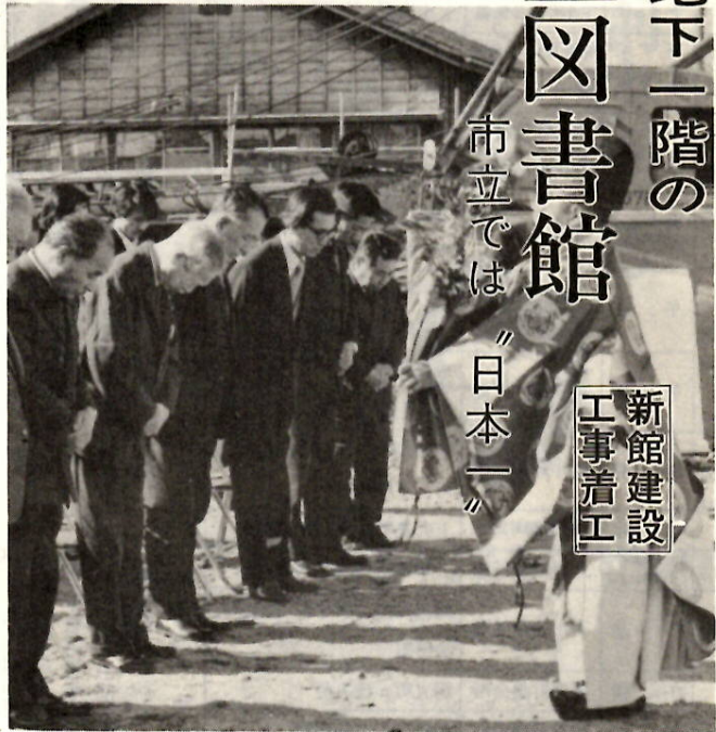
市立日本一をめざす市立図書館の起工式(旧図書館跡)
