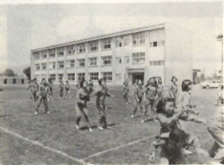
南橋中の新校舎(第一期工事)
