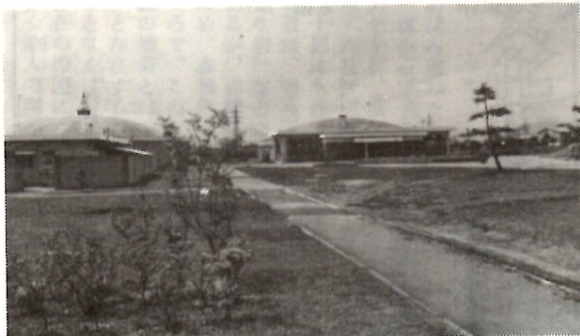
野中浄水場（昭和42年4月竣工）
