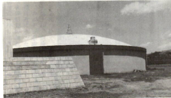
下細井浄水場（昭和50年6月竣工）
