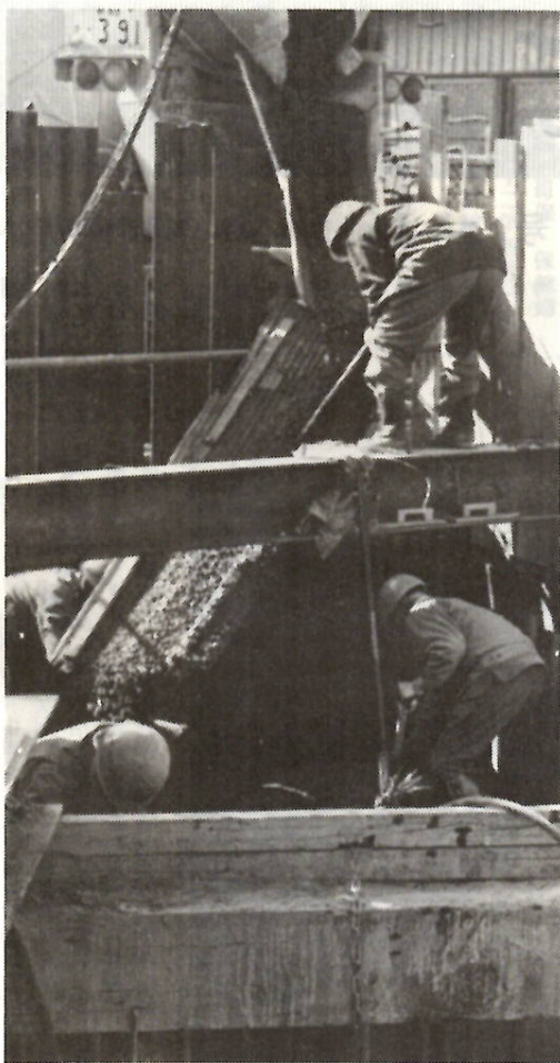
町なかでの下水道管の埋設工事
