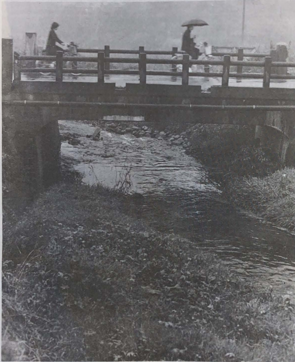
秋雨にけふる八幡川(総社町山澤橋下付近。この下流では改修工事が進んでいる。)
