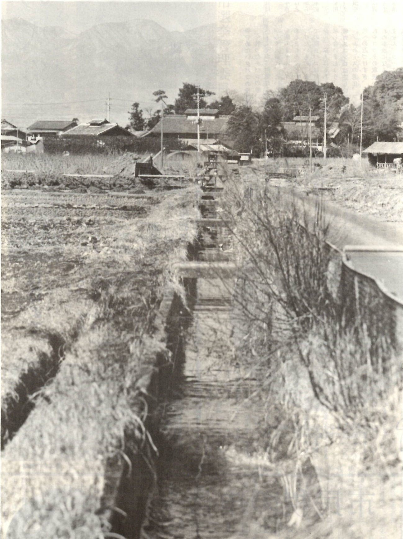
三面コンクリートの用水路となった宮川。西善・山王の部落の背後には様名が見える。
