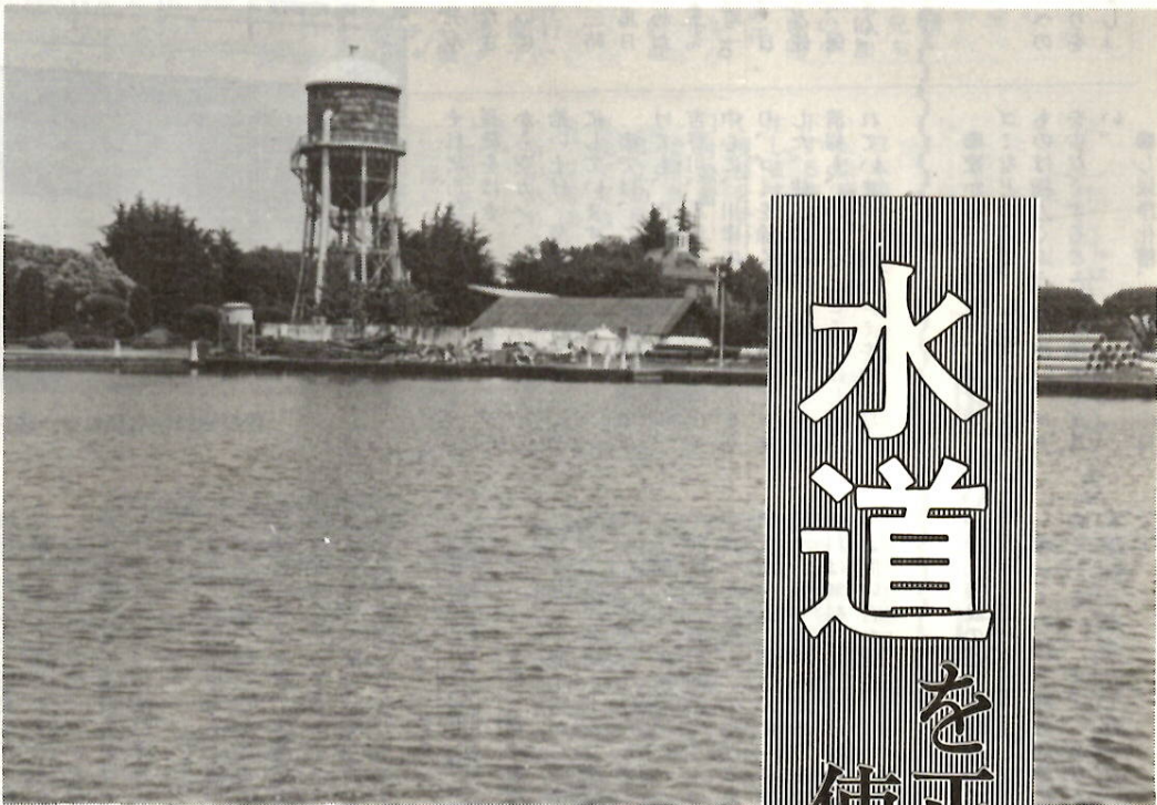
大切な水の源、敷島浄水場
