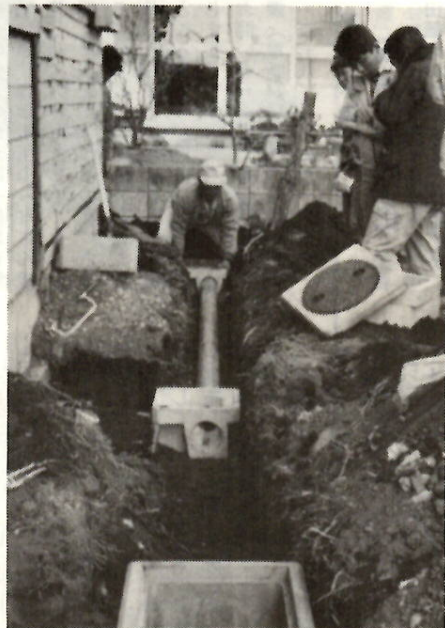
清潔なトイレに——進む水洗便所工事。
