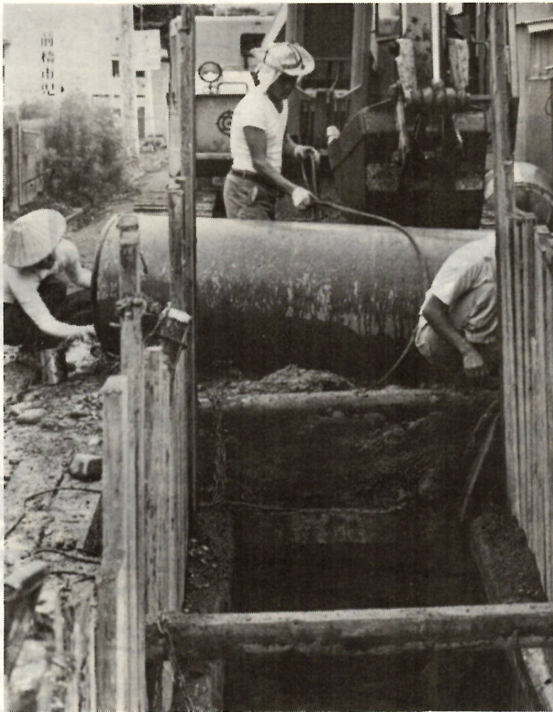
下水道管の埋設工事（日吉町三丁目地内で）
