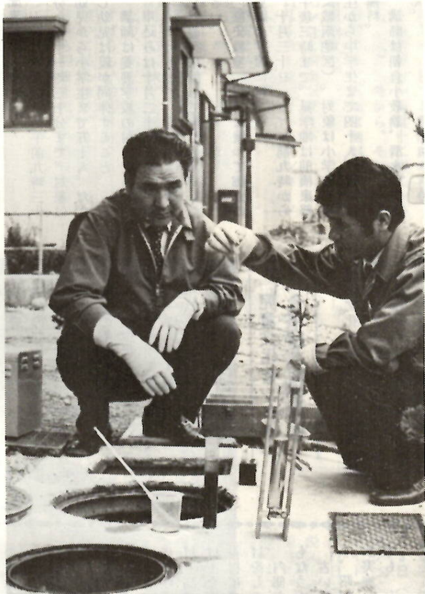
浄化槽が正常な働きをしているか検査を行う管理士
