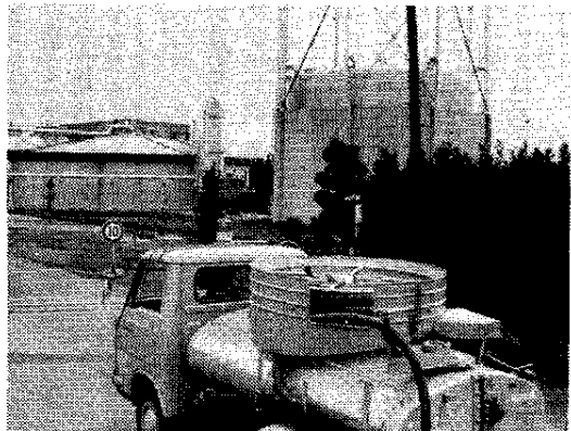
収集したし尿は処理場へ。(六供下水処理場前)
