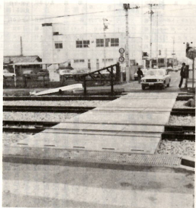
上毛電鉄踏切道構造改良工事（三俣町一丁目地内）
