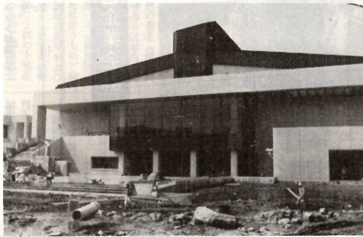
大規模事業完成第1号の市民体育館
