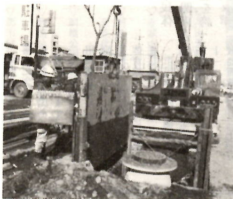
管渠（かんきょ）下水道管の布設工事
