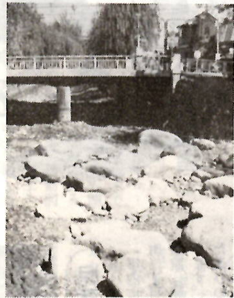
断水中に行われた魚床づくり工事
