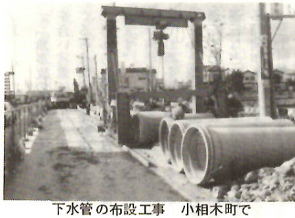
下水管の布設工事 小相木町で
