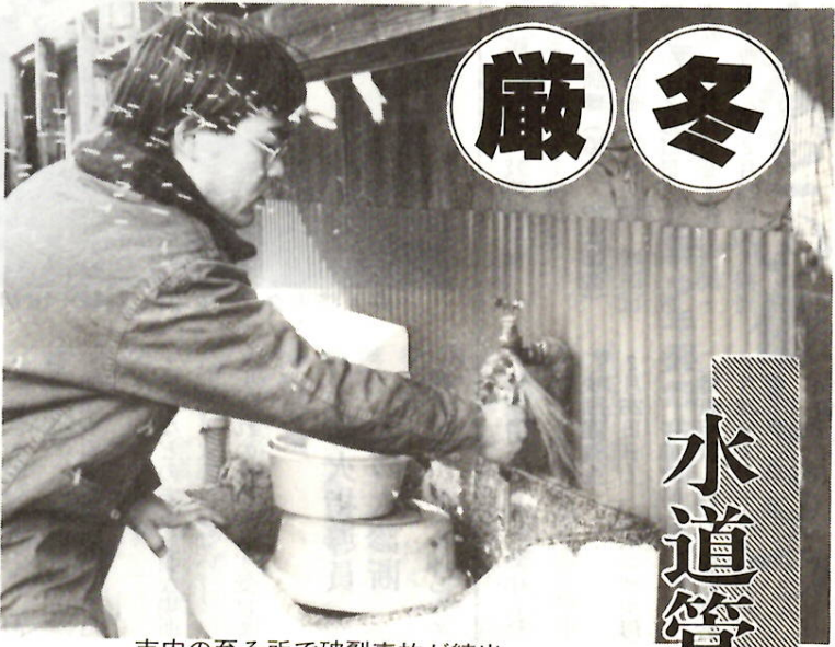
市内の至る所で破裂事故が続出
