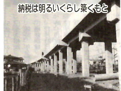
納税は明るい暮らし築くもと 両毛線の高架化工事 下石倉町地内
