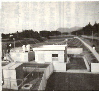
◀新しい最終処分場が完成 11月 埋め立てゴミから出る汚水を地下に浸みこ ませないで集め、浄化処理する処分場です。 総工費は二億四千八百万円。荻窪清掃工場 の二年継続事業。
