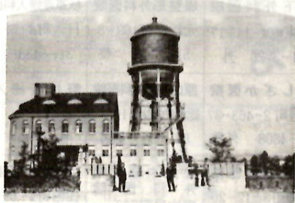
事務所の建物と配水塔
