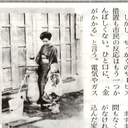
共同用の蛇口「供用栓」
