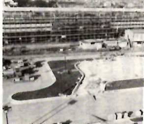
中央広場の工事
