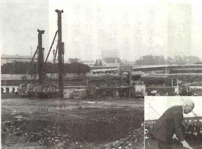
▲工事が始まった市民プール跡の建設現場
