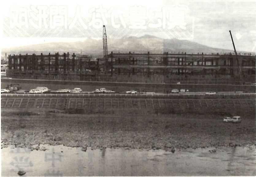
工事が進む前橋公園イベントホール——来年8月に世界自転車大会が開催
