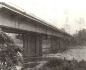
昭和48年に完成の中央大橋
