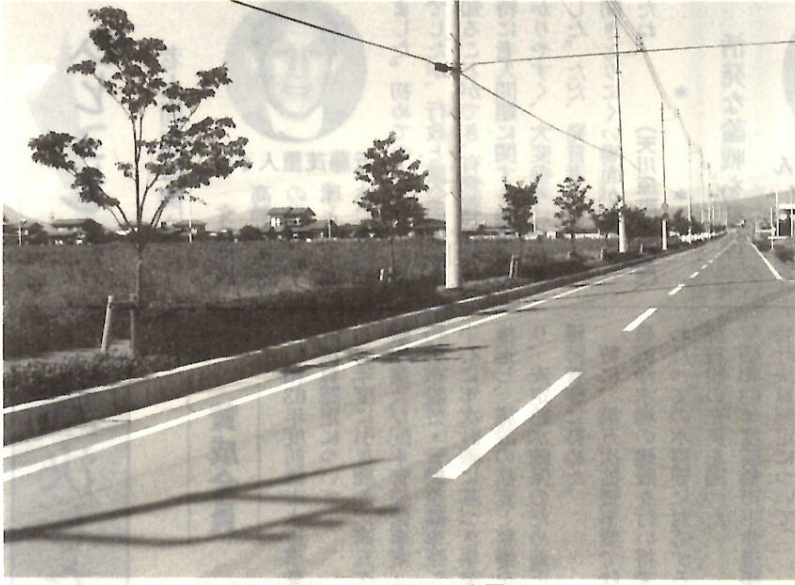
造成が完了した下川淵工業団地
