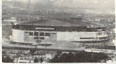
完成間近なグリーンドーム前橋
