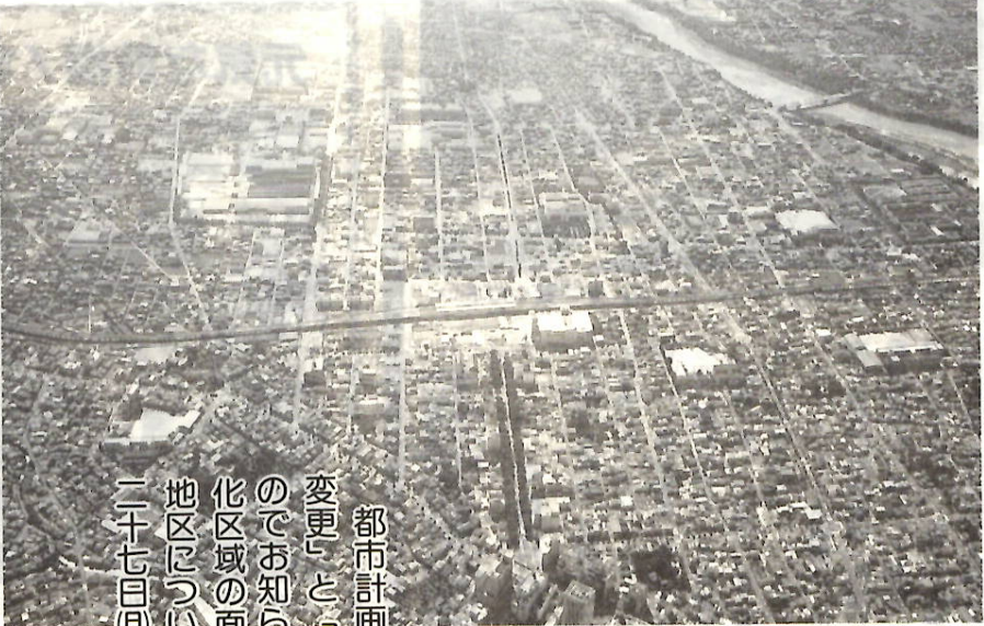
上空から市街地南部を望む(中央は前橋駅)
