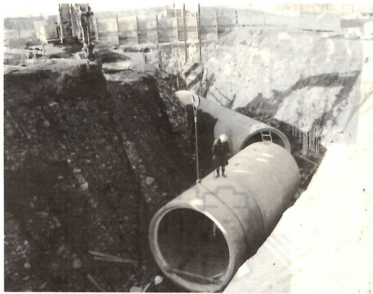
内径240mmの下水管の埋設工事が着々と進みます 川原町
