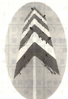
新六供工場の煙突
