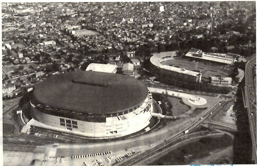
① グリーン・ドーム前橋 右奥は旧競輪場
