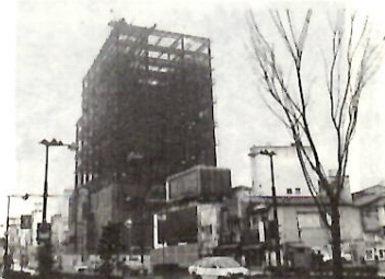
建設工事が進む勤労者センター
