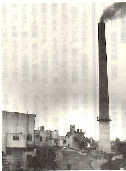
亀泉清掃工場
