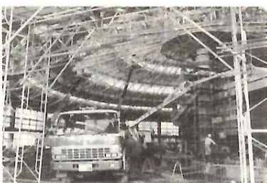
着々と工事の進む六供温水プール
