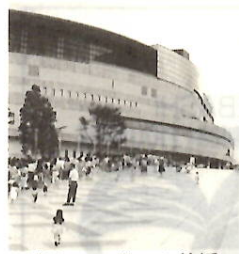
グリーン・ドーム前橋
